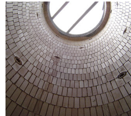
耐酸煉瓦ライニング(缶体内部)
